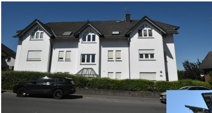
Ansicht von der Straße aus
