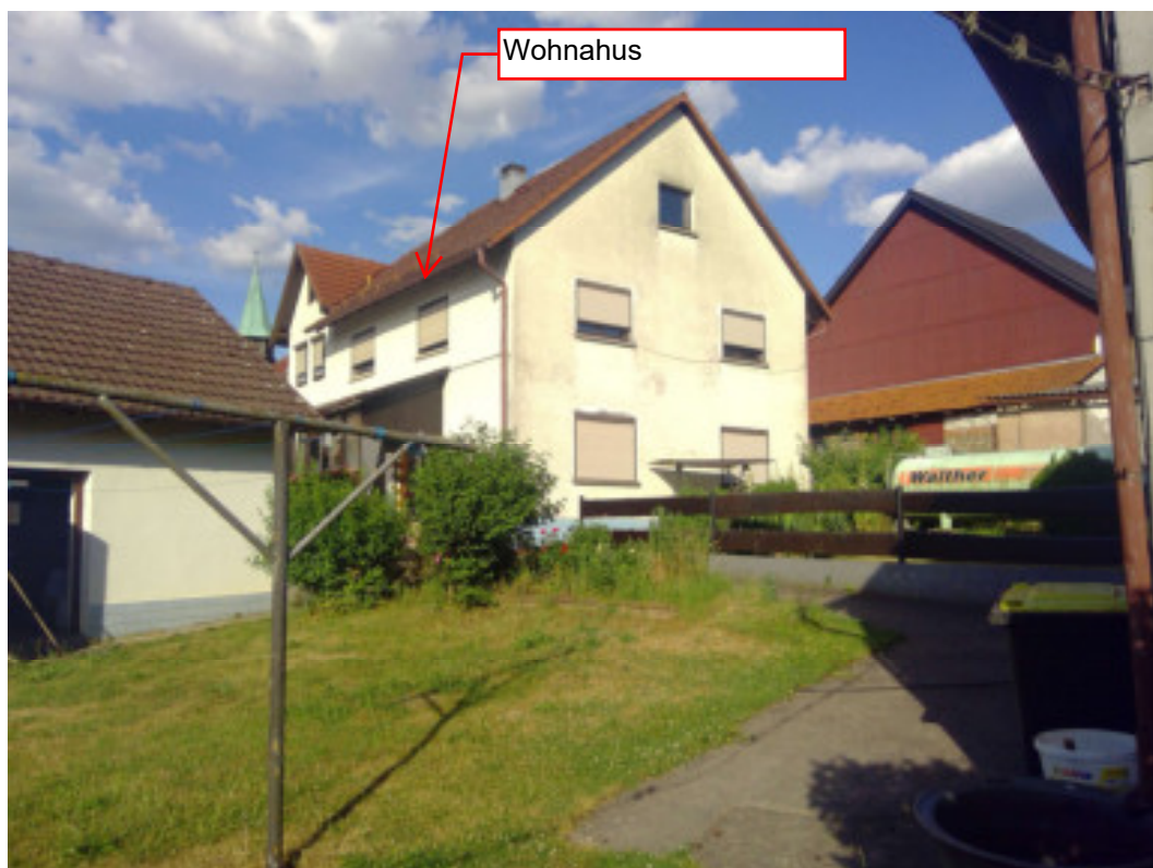
Blick vom Flurstück 209/6 in nordöstliche Richtung
