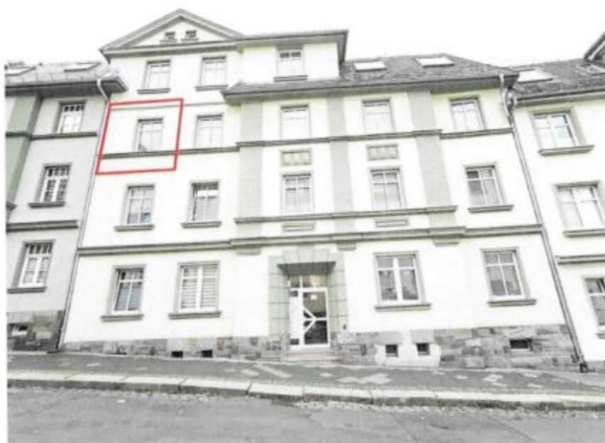
Bild 2: Straßenansicht des Hauses Robert-Koch-Str. 38 (mit Kennzeichnung der Lage des Sondereigentums)
