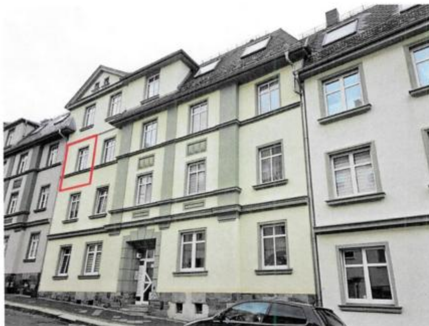
Bild 3: Straßenansicht des Hauses Robert-Koch-Str. 38 (mit Kennzeichnung der Lage des Sondereigentums)
