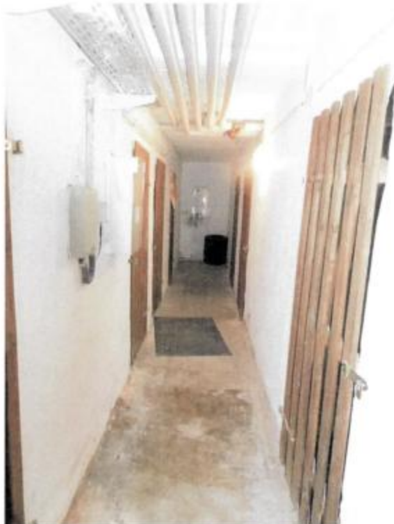
Bild 9: Kellergang des Hauses Robert-Koch-Str. 38
