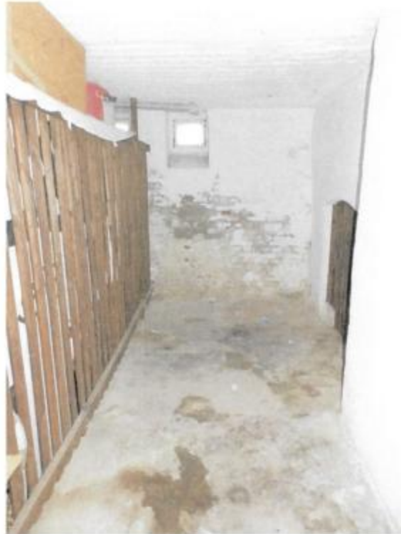
Bild 11: ein Kellerraum (Mieterkeller) des Hauses Robert-Koch-Str. 38
