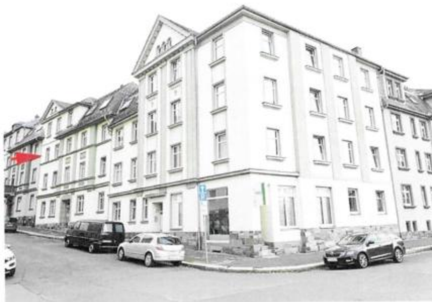
Bild 18: Straßenansicht der Häuser Robert-Koch-Str. 36 und 38 (mit Kennzeichnung der Lage des Sondereigentums)
