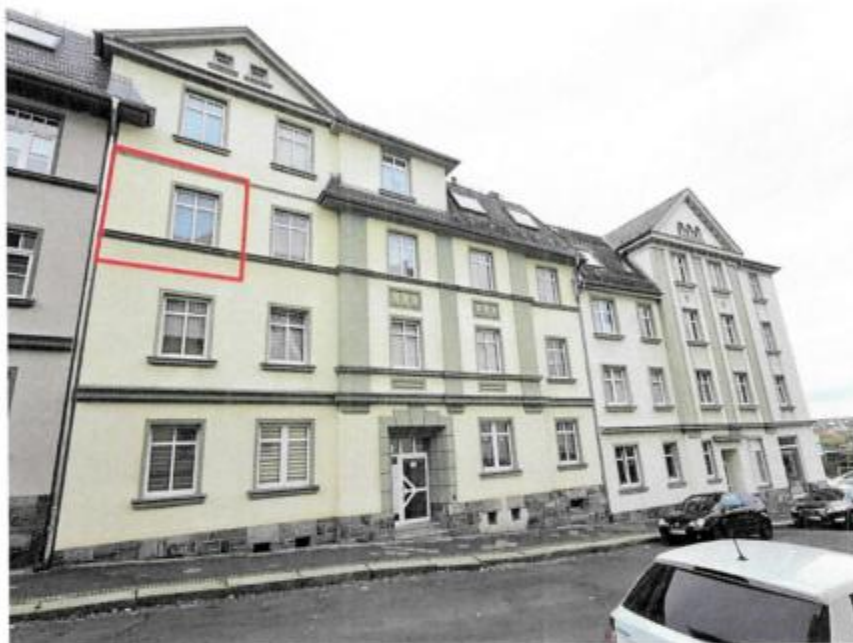
Bild 1: Straßenansicht des Hauses Robert-Koch-Str. 38 (mit Kennzeichnung der Lage des Sondereigentums)
