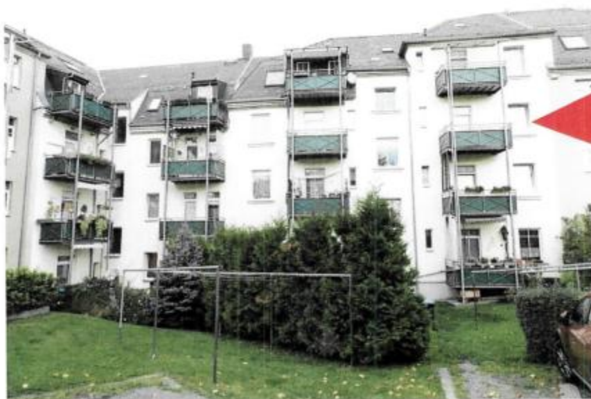
Bild 4: Ansicht des Hauses Robert-Koch-Str. 38 vom rückwärtigen Nachbargrundstück aus (mit Kennzeichnung der Lage des Sondereigentums)
