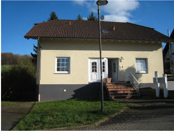
Bild Nr. 1, Straßenansicht. Links u. rechts vom Gebäude befinden sich Parkplätze.
