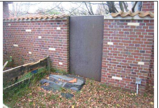
Grenzmauer nach Norden
