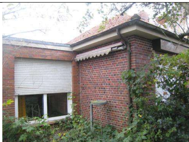
Ansicht von Südwesten: Anbau
