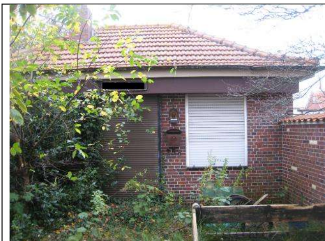
Ansicht von der Straße (Osten): Eingang
