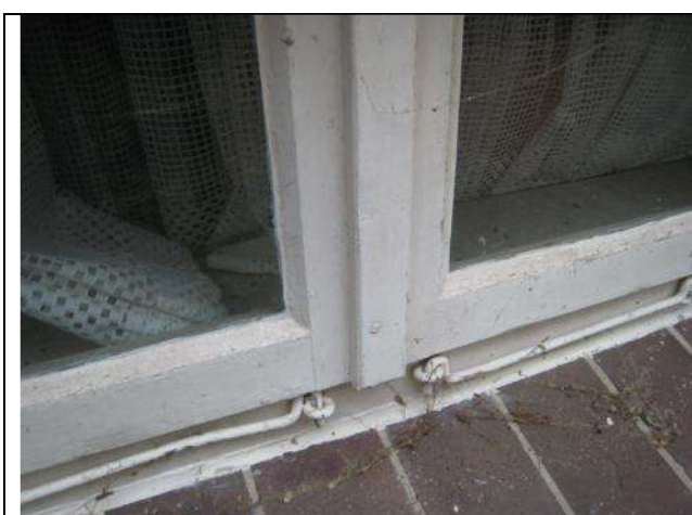
Fenster Ostseite: Einfachverglasung
