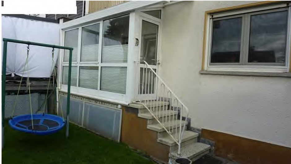
Wintergarten mit Freitreppe
