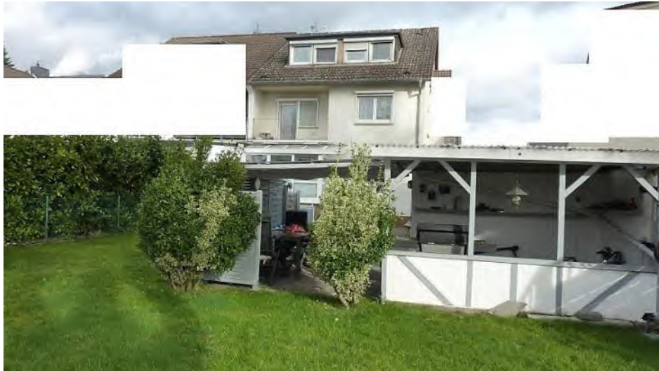
Rückansicht Wohngebäude / Überdachung - Garage
