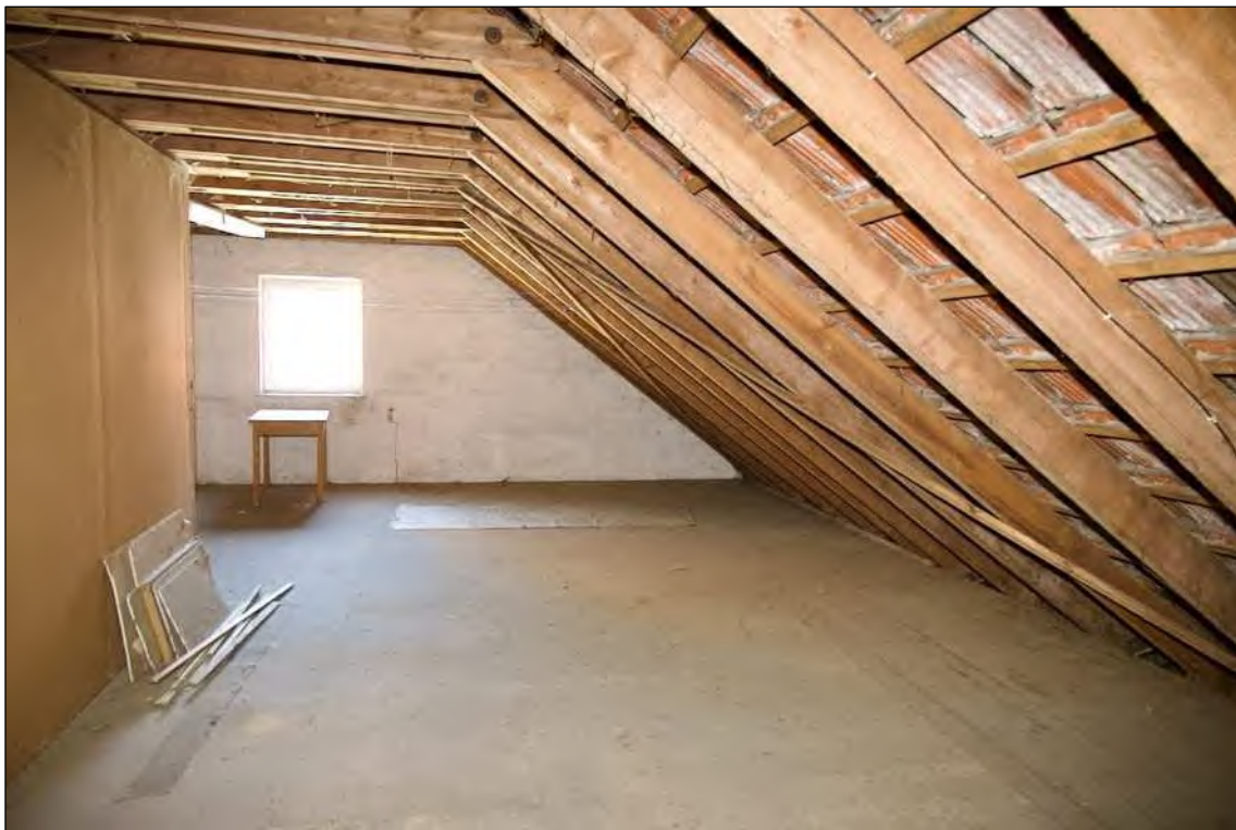
Foto 16 nicht ausgebauter Dachraum
