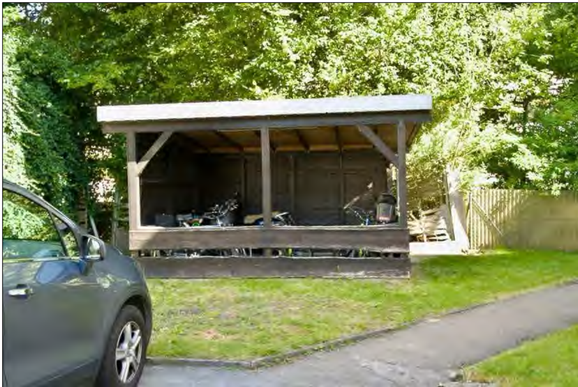
Foto 5 Fahrradabstellplatz, die Überdachung befindet sich teilweise auf Flurstück 67/1, nach Auskunft der Antragsgegnerin wurde die Überdachung durch den Eigentümer des Nachbargrundstücks Flurstücks 68/17 errichtet.
