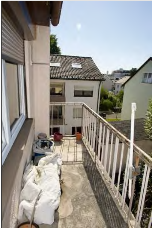
Foto 11 Obergeschoss - Wohnung 2, Balkon
