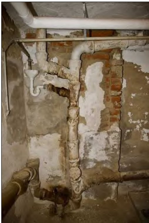
Foto 20 Kellergeschoss - Abwasserinstallationen
