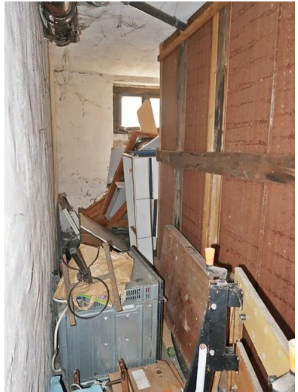
Kellerraum mit Sperrmüllablagerungen
