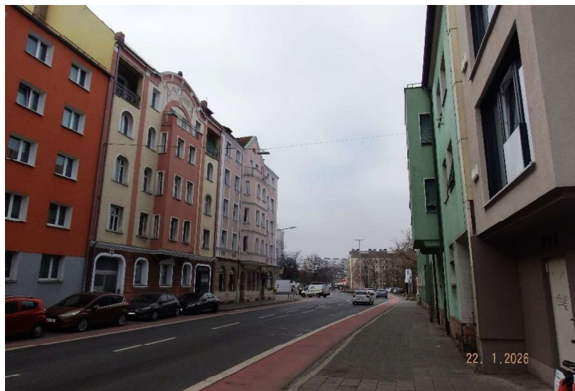
Umgebungsbebauung Richtung Westen
