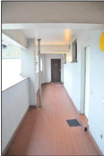
Laubengang Gebäudeteil Marktsraße
