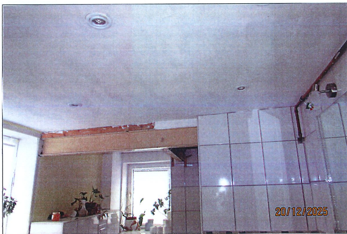
Abbildung 16: Zugangsbereich bauseitig im Rohbauzustand bezogen auf obiges Foto.
