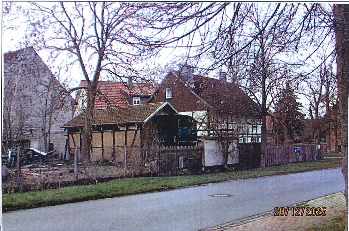
Abbildung 7: Blick auf das zugehörige Nebengebäude mit Grundstückszufahrt.
