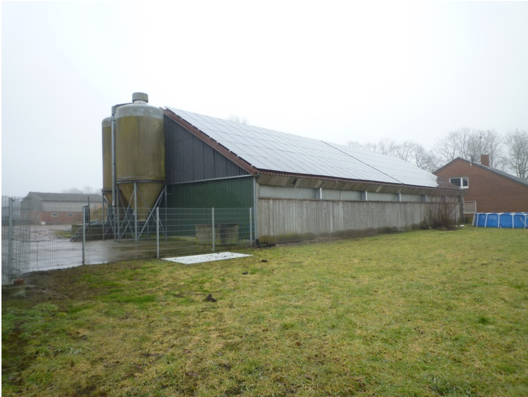
Photovoltaikanlage Nr. 1 / eh. Boxenlaufstall
