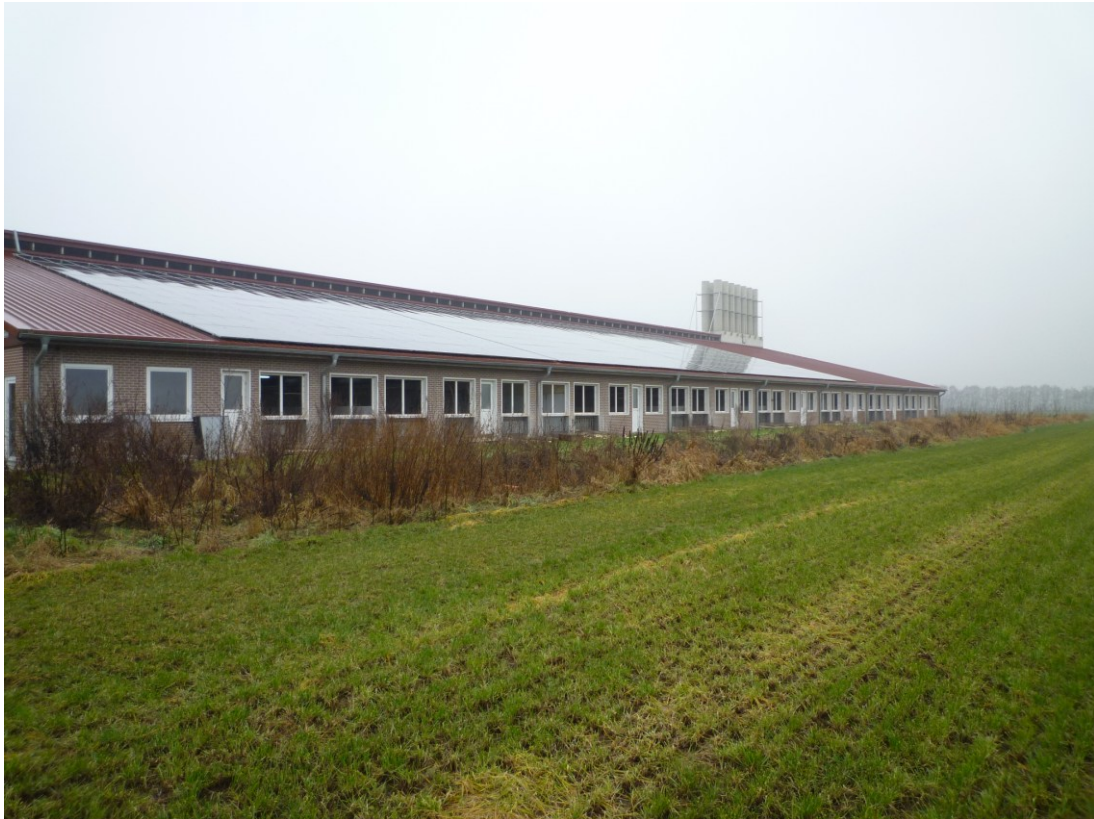
Photovoltaikanlage Nr. 2 / Schweinemaststall (Baujahr 2022)
