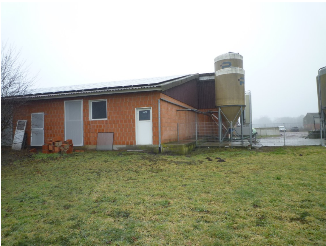
Photovoltaikanlage Nr. 1 / Schweinemaststall (Baujahr 2008)
