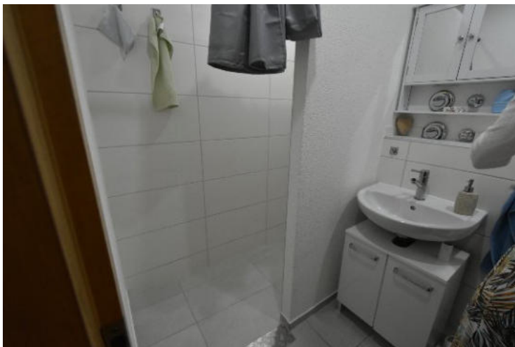
Bild 14: Wohnung EG mitte – Bad
