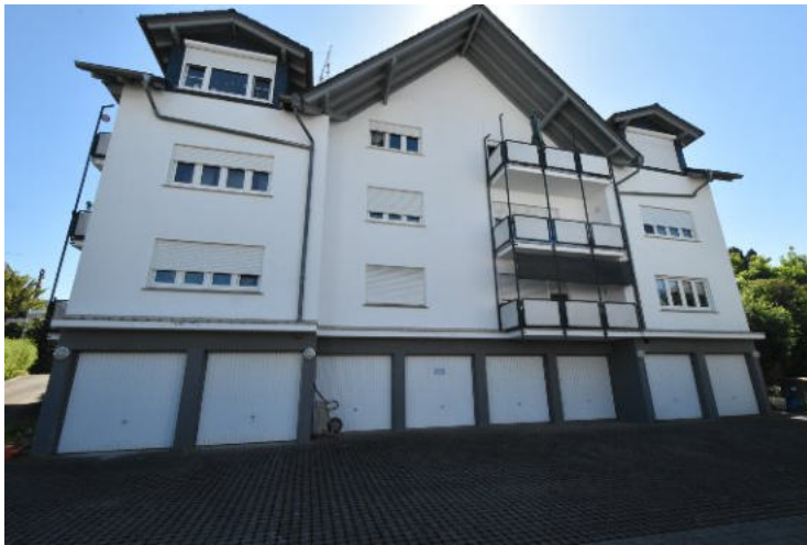
Bild 1: Rückseite des Gebäudes
