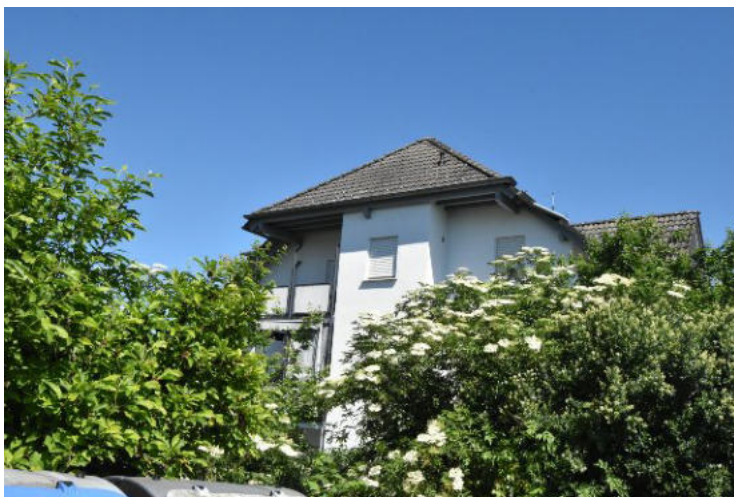
Bild 3: Linke Giebelseite von der Straße aus
