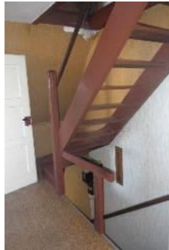
Treppe zum DG
