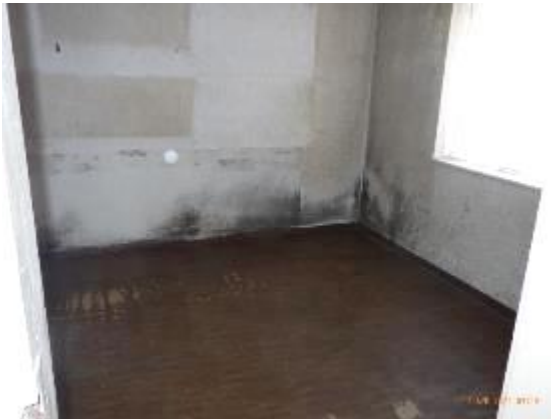
Innenansichten EG Küche
