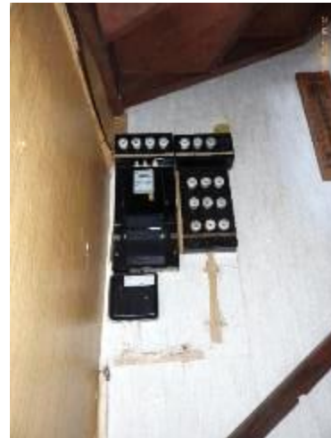
Elektro-Zähler und Haussicherungen
