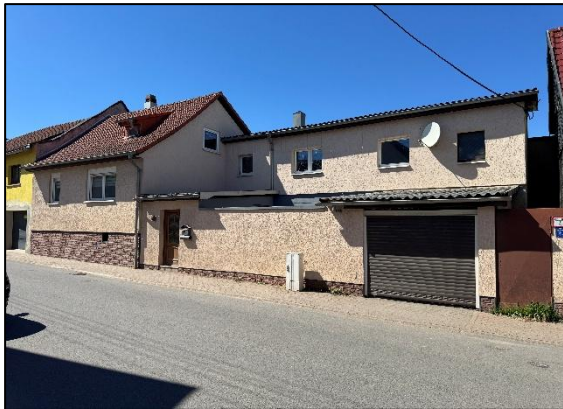
Straßenansicht - Einfamilienhaus & Anbau sowie Garage
