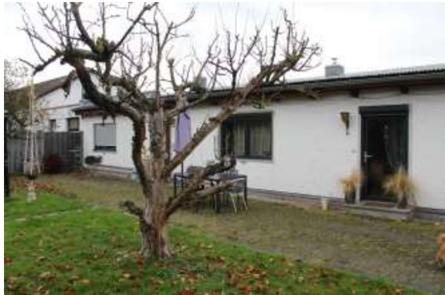
Bild 4: Ansicht Nordostseite Wohnhaus von Norden
