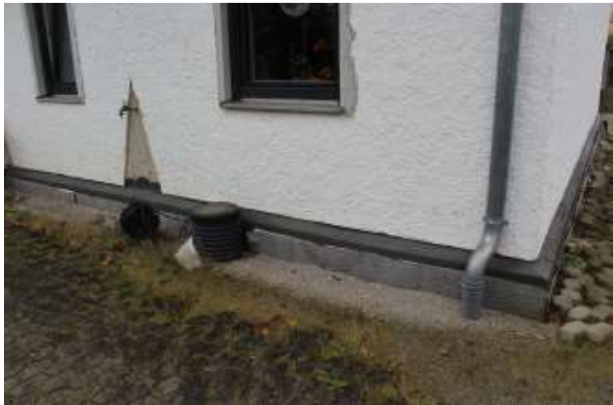
Bild 11: Ansicht Nordecke Wohnhaus -Sockel-
