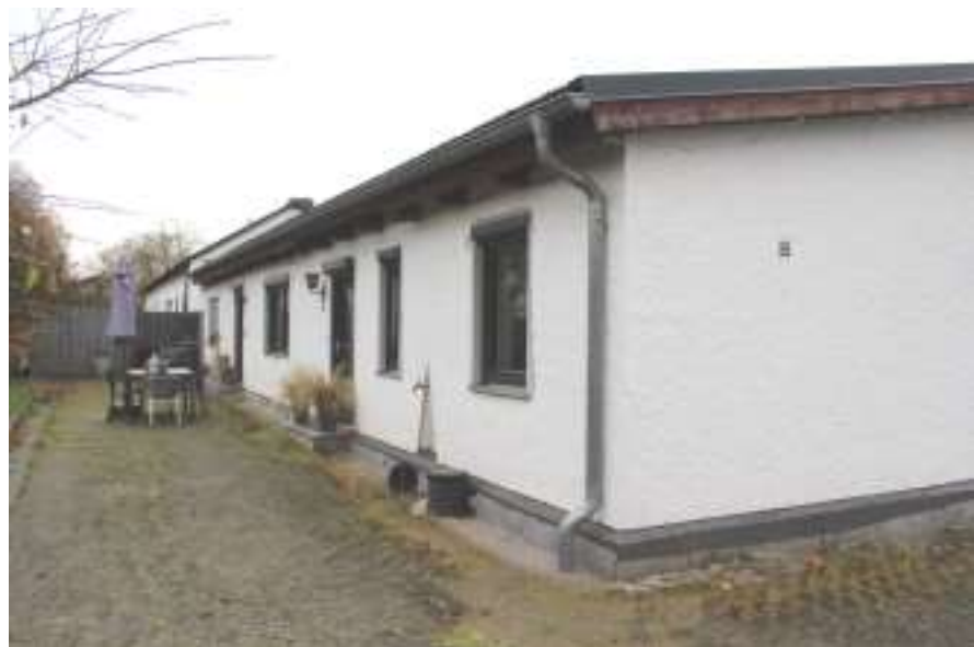
Bild 5: Ansicht Nordostseite Wohnhaus von Nor- den
