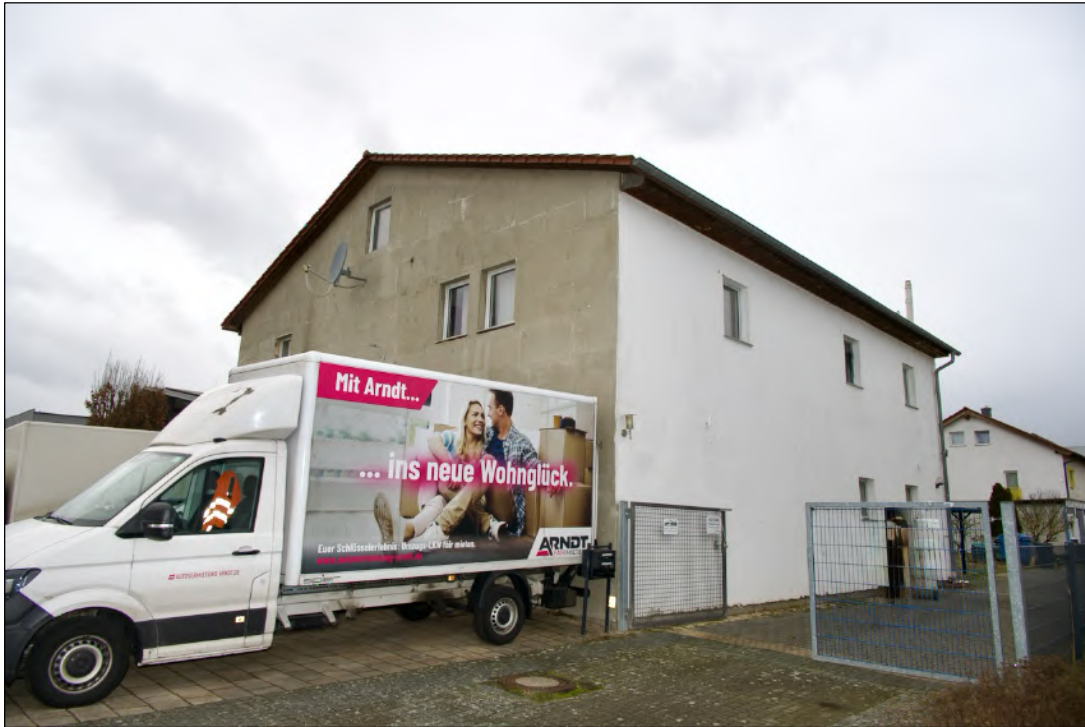
Foto 3 Lagerhalle mit Büro - Ansicht von Osten
