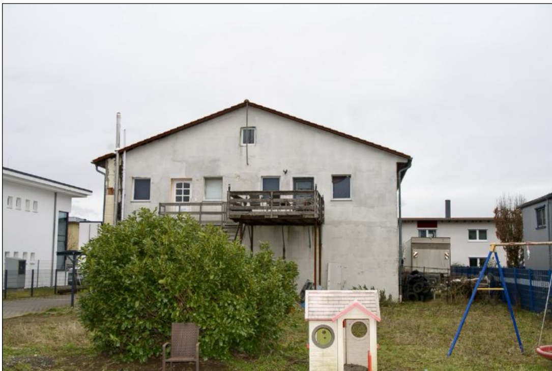
Foto 4 Lagerhalle mit Büro - Ansicht von Norden
