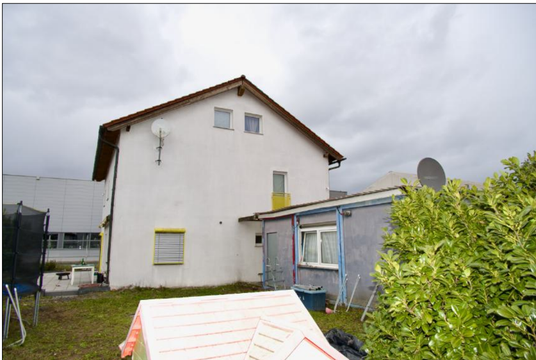
Foto 16 Betriebsinhaberwohnhaus - Ansicht von Süden
