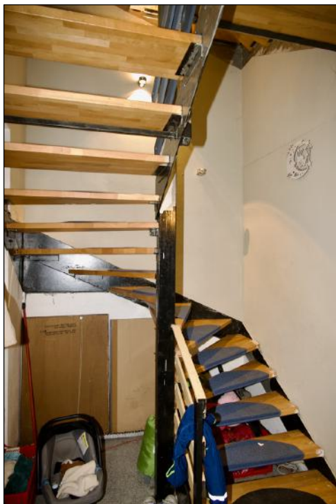
Foto 22 Betriebsinhaberwohnhaus - Erdgeschoss, Treppe zum Obergeschoss
