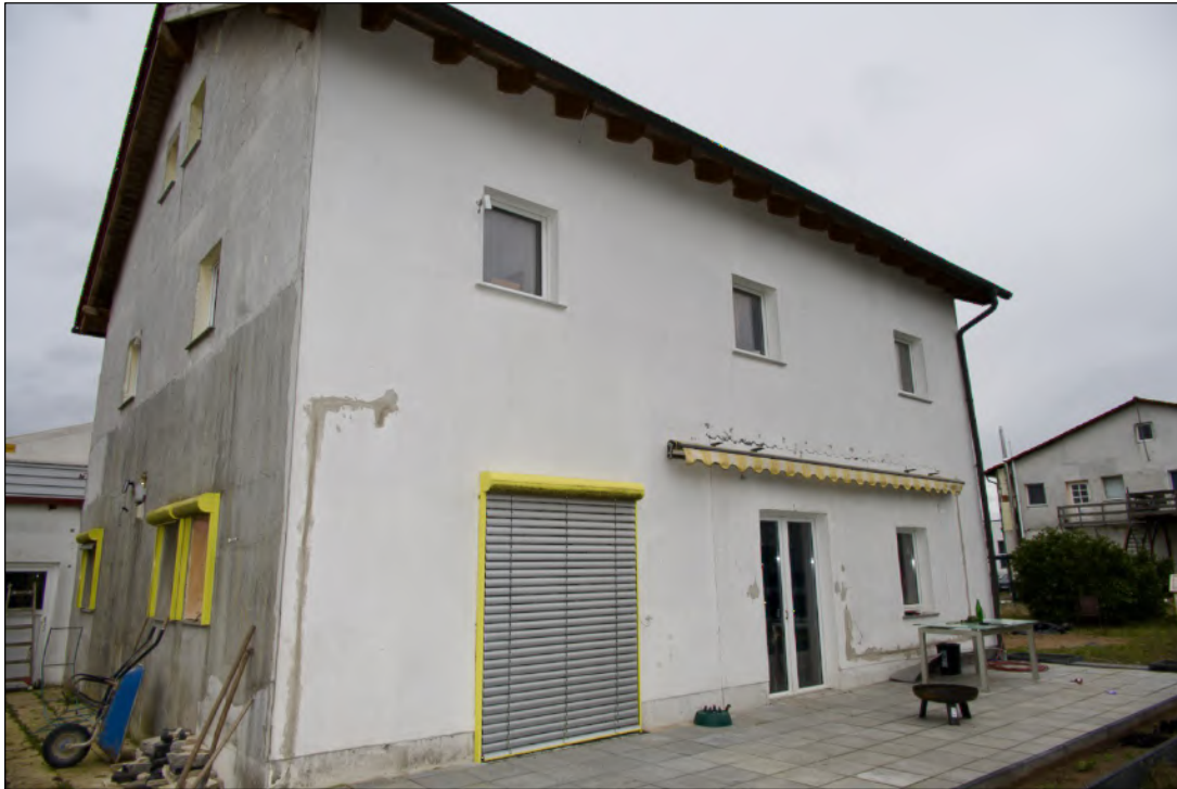
Foto 17 Betriebsinhaberwohnhaus - Ansicht von Westen
