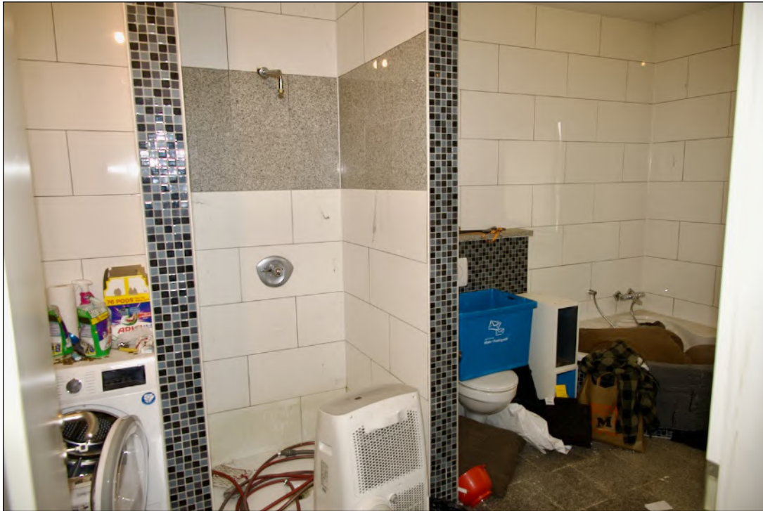
Foto 11 Lagerhalle mit Büro - Obergeschoss
