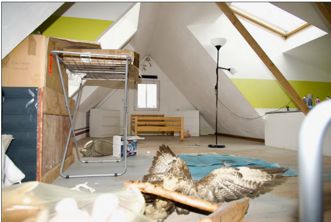
Foto 14 Lagerhalle mit Büro - ausgebauter Spitzboden (die bauordnungsrechtliche Zulässigkeit wurde nicht geprüft)
