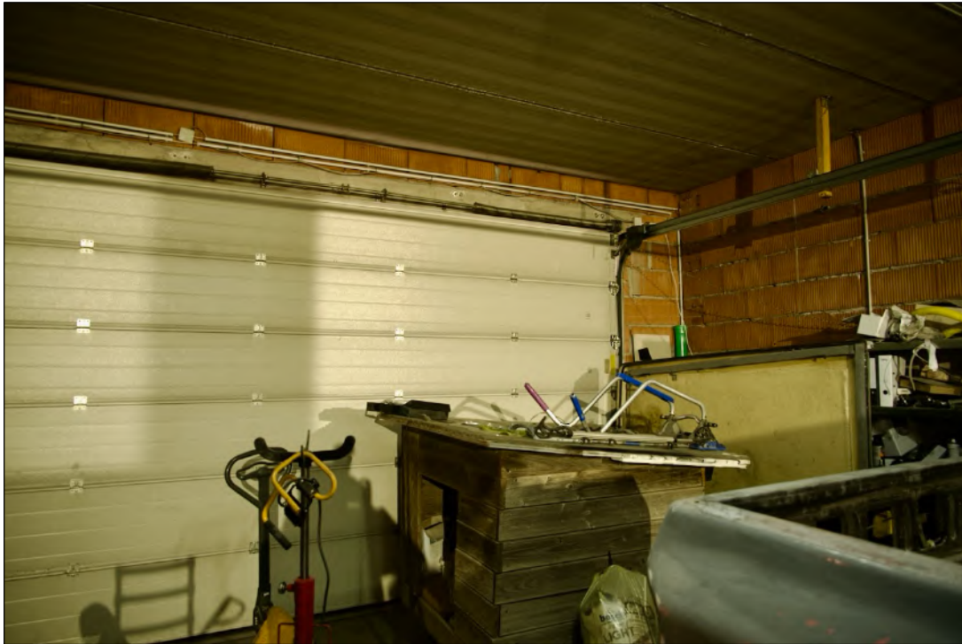
Foto 7 Lagerhalle mit Büro - Erdgeschoss
