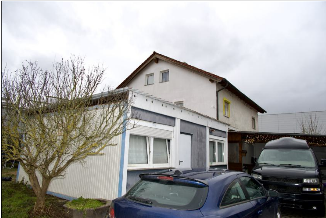
Foto 15 Betriebsinhaberwohnhaus - Ansicht von Osten
