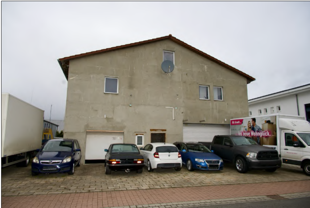
Foto 1 Lagerhalle mit Büro - Straßenansicht von Süden
