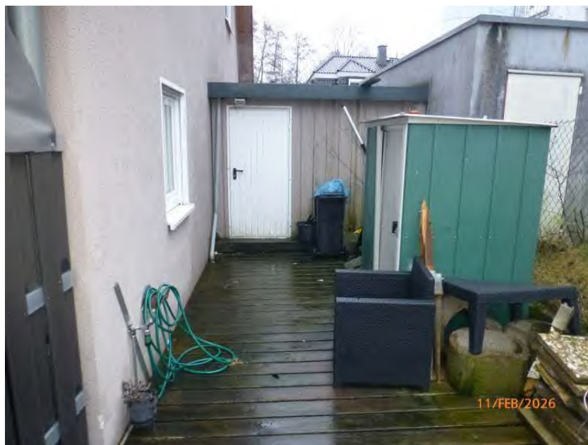
Nebengebäude Garage und Gartenhaus
