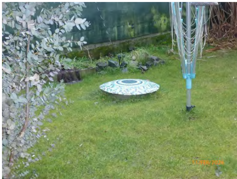
Gasttank unterirdisch im Garten
