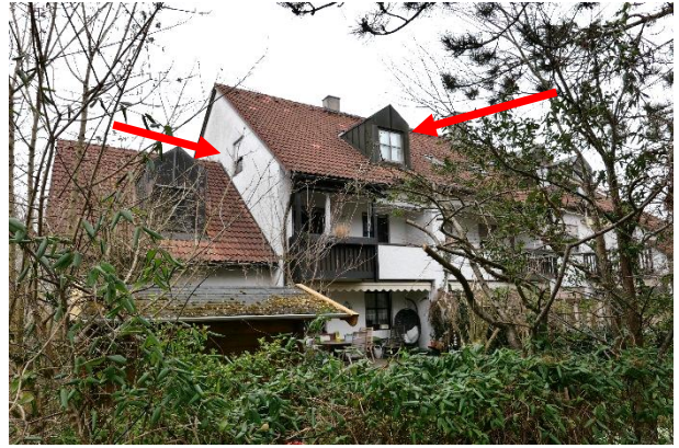
Ansicht von Westen, Wohnung markiert
