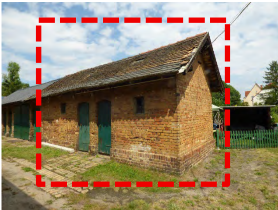
Foto 3: Hofansicht auf Nebengebäude mit anschließenden, nachbarlichen Nebengebäude
