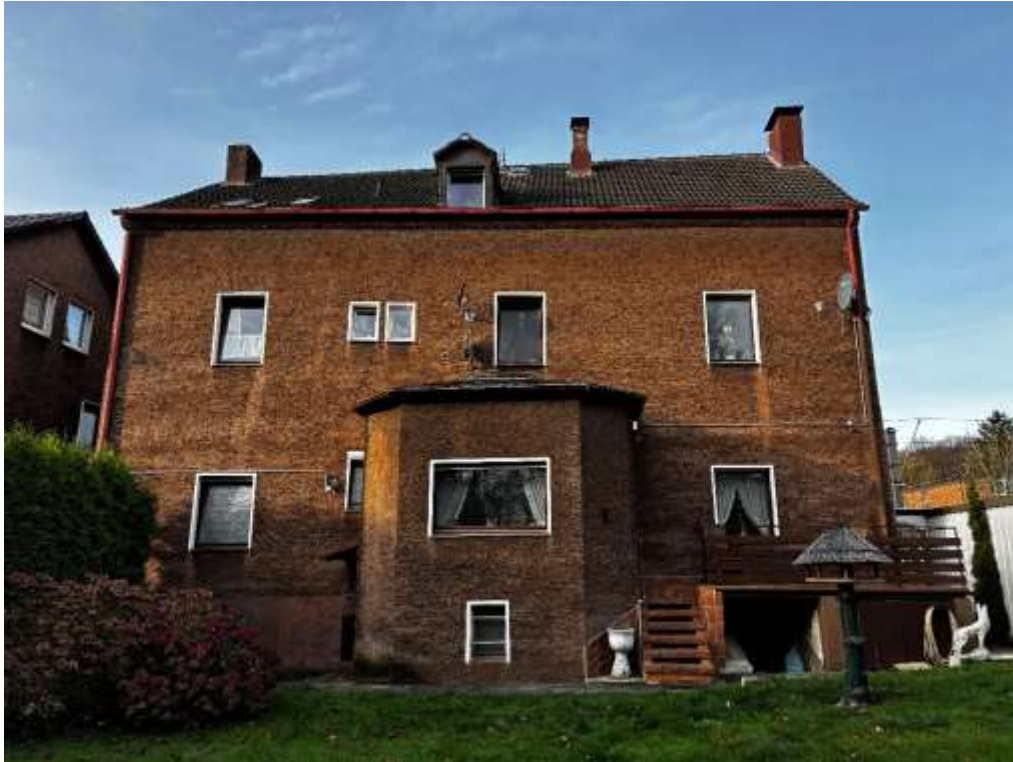
Ansicht von Osten (Gartenansicht)
