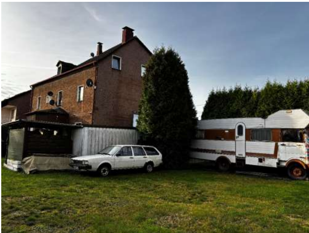
Ansicht von Nordosten, im Vordergrund unbebauter Grundstücksteil
