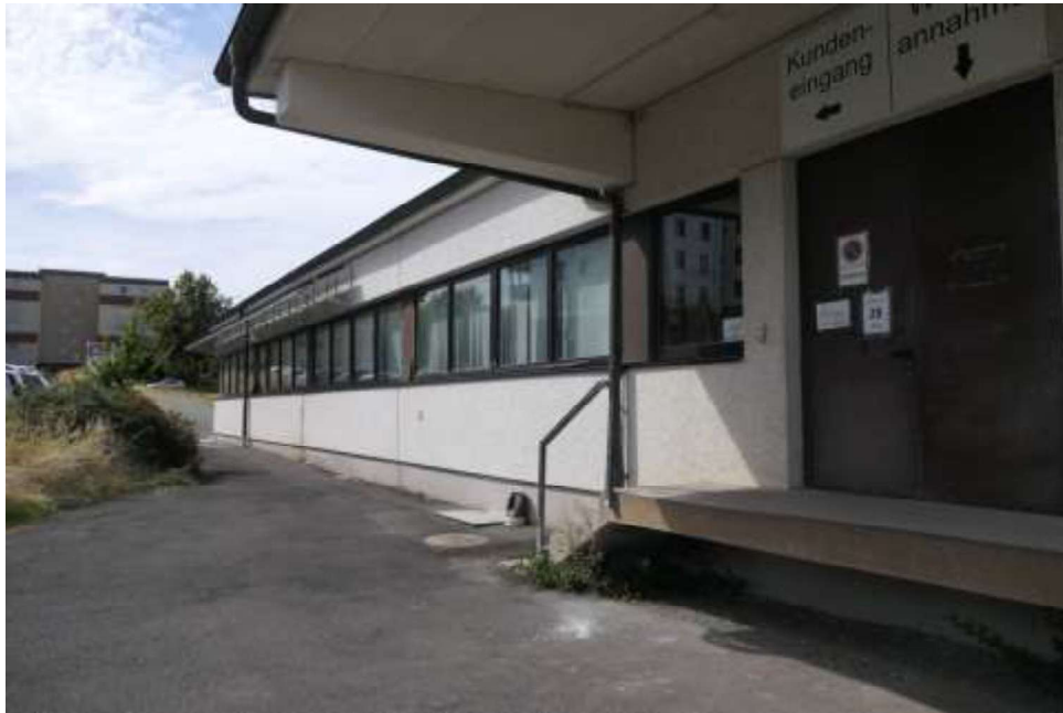
Bild 3: Straßenseite des Bewertungsobjekts Erdgeschoss zum Reutlichweg
