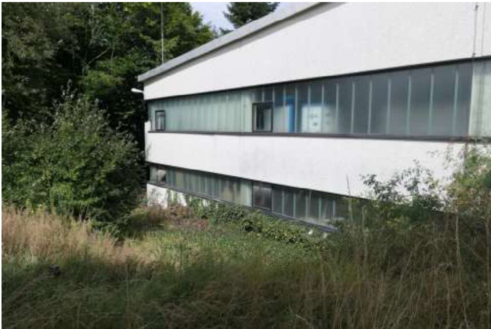
Bild 2: Südwestseite Erdgeschoss und Untergeschoss
