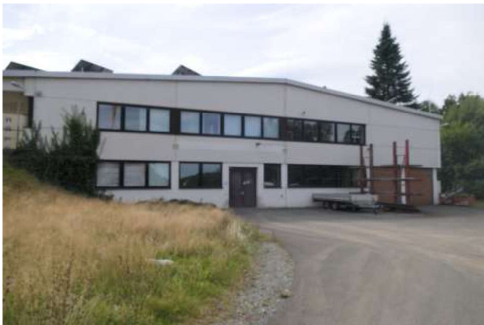
Bild 4: Eingangsbereich zum Untergeschoss in Nordöstliche Richtung
