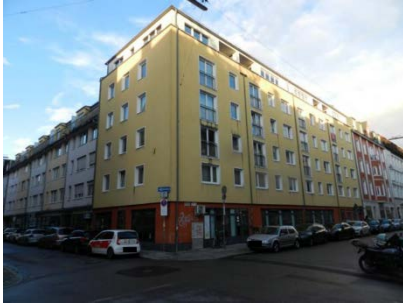
Ansicht von Südwest von der Kreuzung Erzgießereistraße/ Kreittmayrstraße
