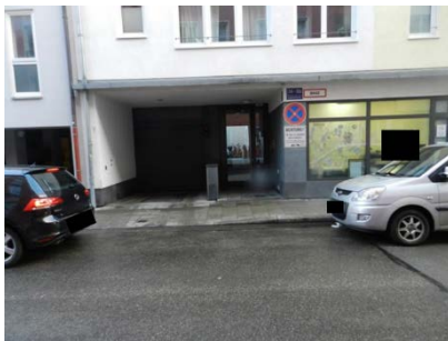
TG-Ein-/Ausfahrt bei Gebäude Erzgießereistraße 34
