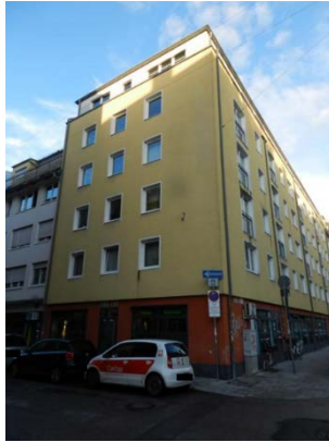
Ansicht von Südwest von der Kreuzung Erzgießereistraße/ Kreittmayrstraße
