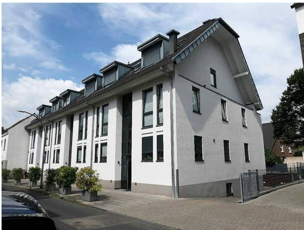
Straßenansicht von Südosten
