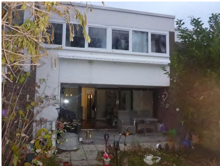
Ansicht von Südwesten / Terrasse
