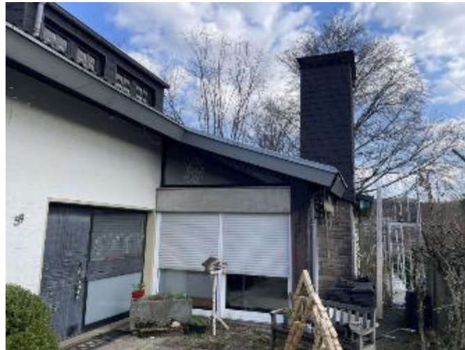
Hauseingang und Kaminzimmeranbau
