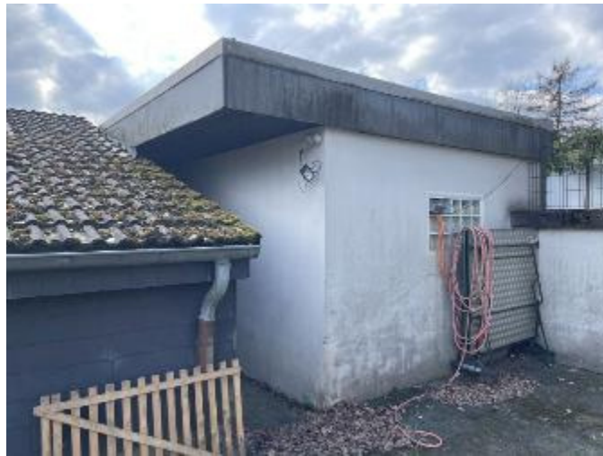
Rückwärtige Ansicht Pkw-Garage
