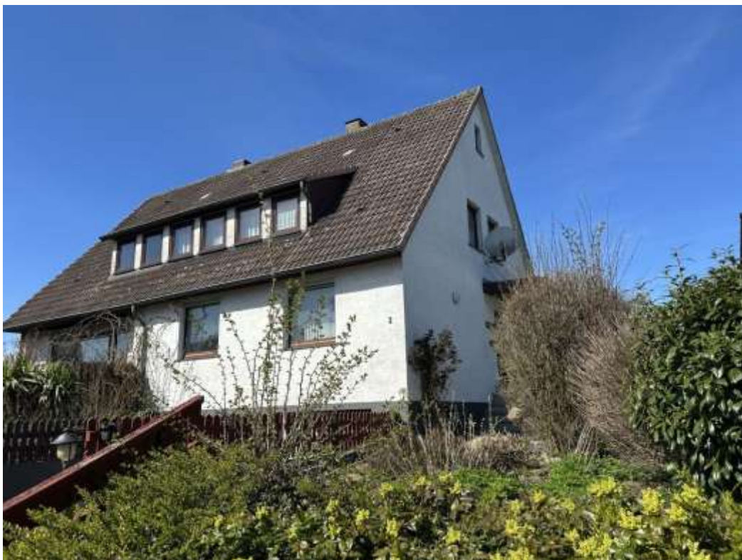
Anlage 5.2: Bild 2 Ansicht von Südosten
