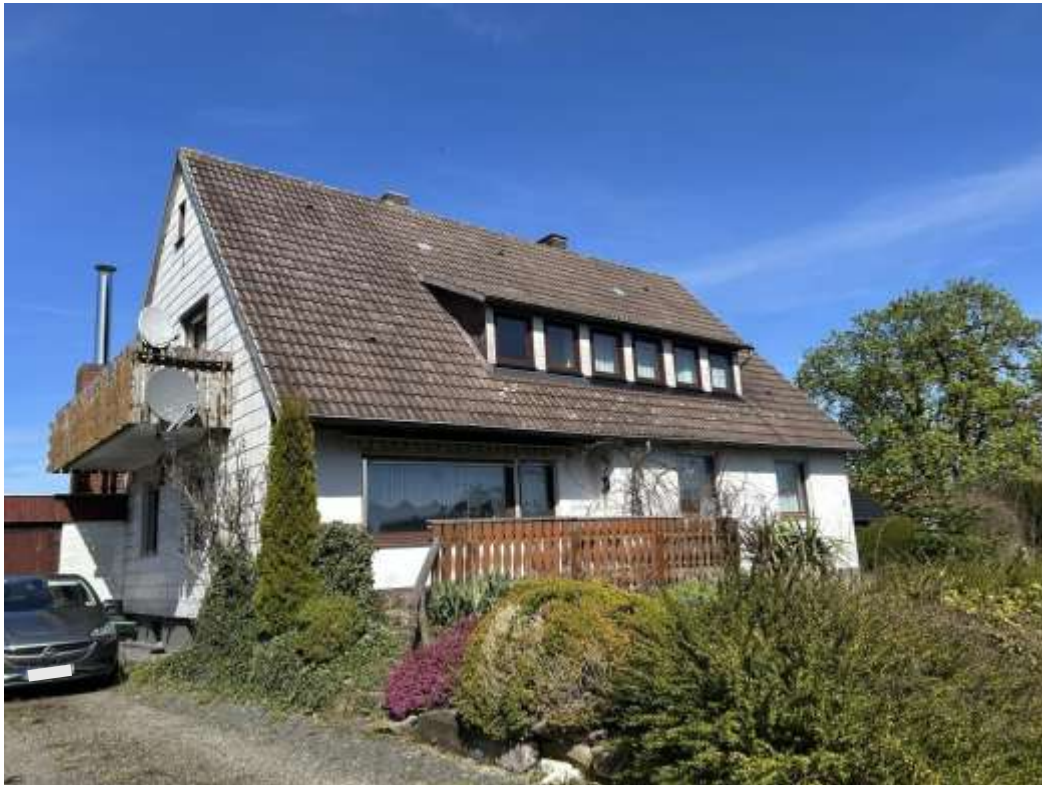
Anlage 5.3 Bild 3 Ansicht von Südwesten
