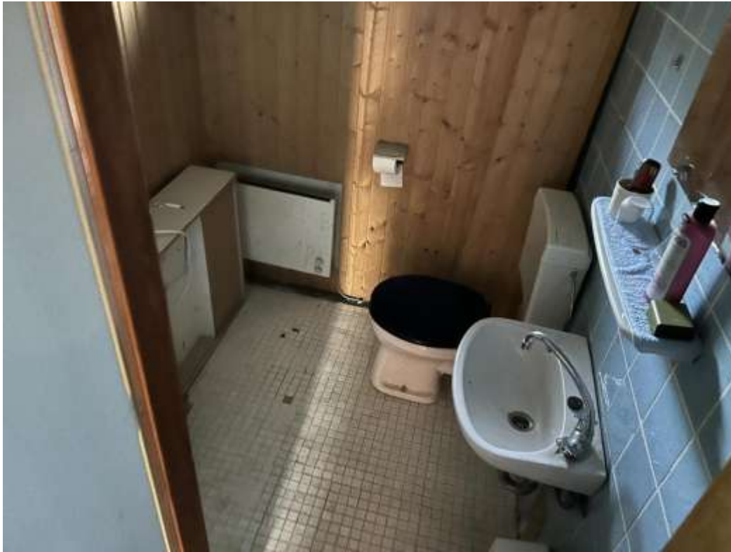
Anlage 5.11: Bild 11 WC und Waschraum im Kellergeschoss
