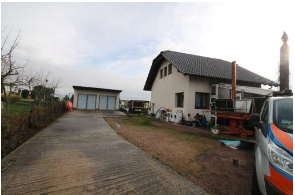
Westansicht mit Doppelgarage
