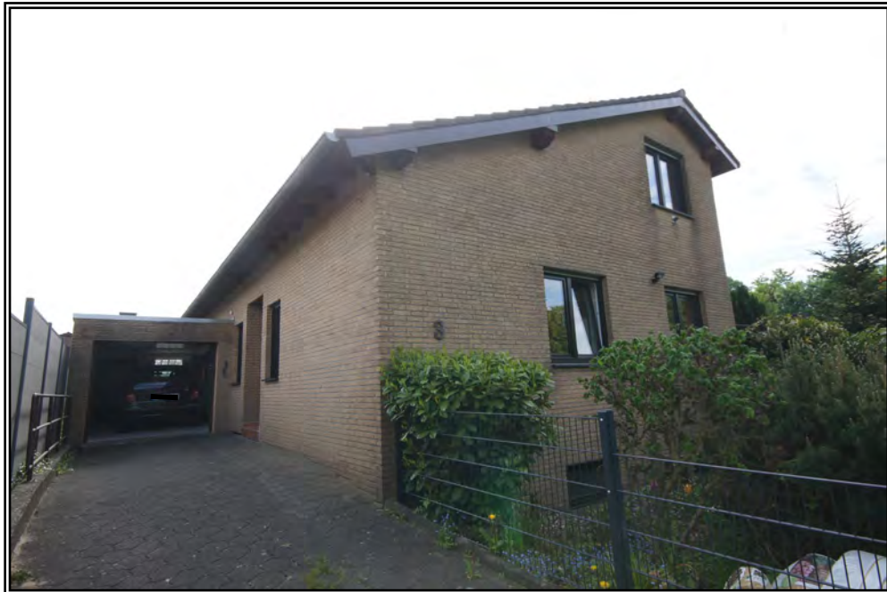
Eingangsbereich und Garagenzufahrt von Westen
