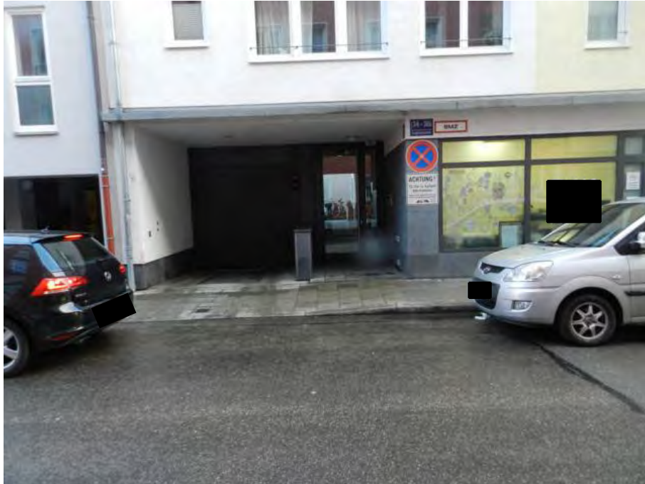
TG-Ein-/Ausfahrt bei Gebäude Erzgießereistraße 34
