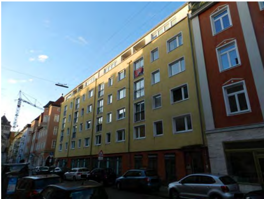
Ansicht von Süden von der Kreittmayrstraße
