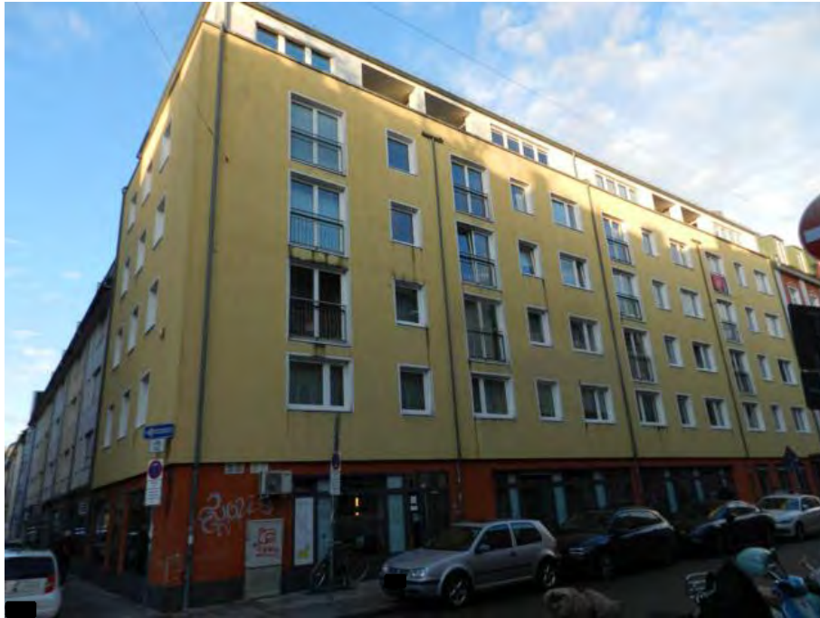
Ansicht von Süden von der Kreittmayrstraße
