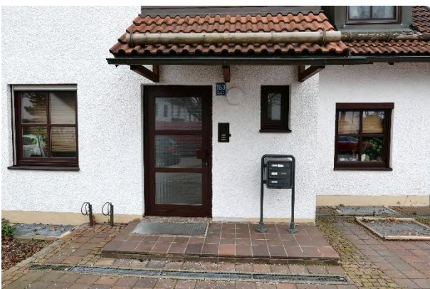
Hauseingang von Osten
