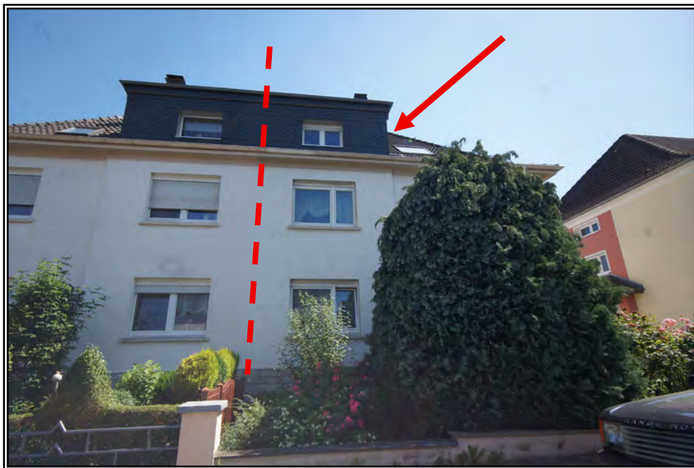
Ansicht von Südwesten (nur rechte Gebäudehälfte)
