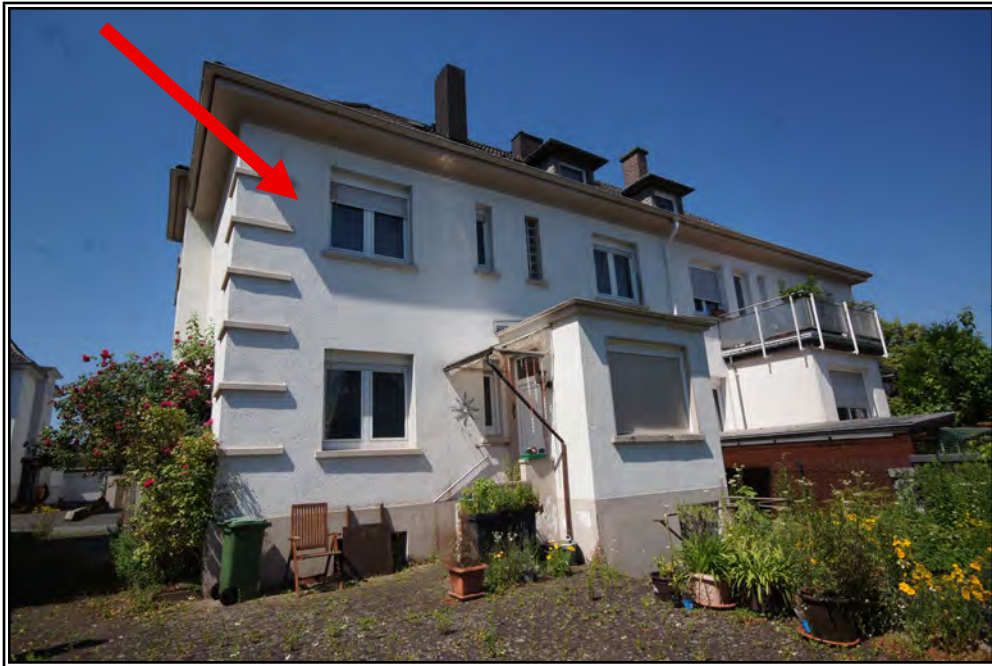
Rückwärtige Ansicht von Osten (linke Gebäudehälfte)
