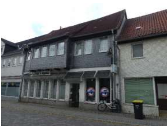
Straßenansicht des Grundstücks
