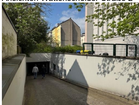
Einfahrt Tiefgarage Wattenscheider Str. 2
