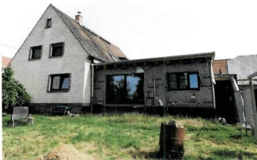
Bild 5: Ansicht des Einfamilienhauses aus südlicher Richtung (im Bild links: Vorderhaus)
