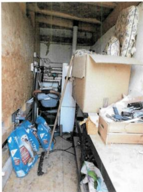
Bild 7: Anbau an Hinterhaus (Heizungsraum)
