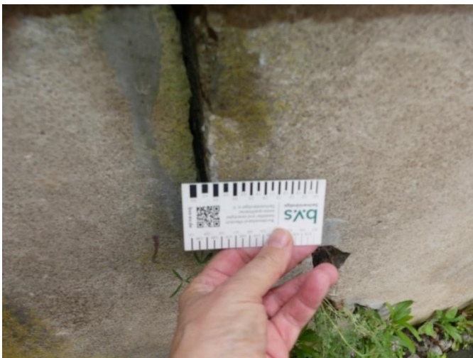
Massive Risse in der Stützmauer zur Straße
