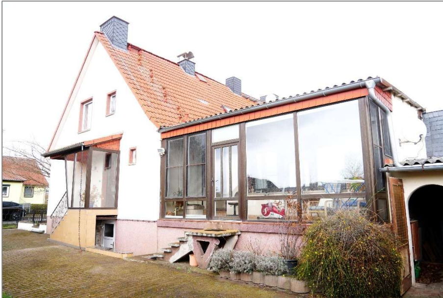
Wohnhaus mit ostseitigem Anbau - Südostansicht
