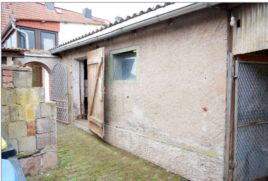
ehemaliger Stall - Südostansicht
