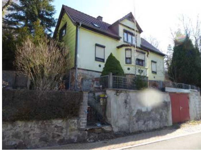
Blick von der Straße „Glückaufsweg“
