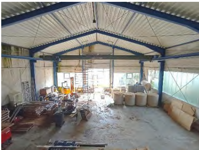
18 – Blick aus Bürotrakt
