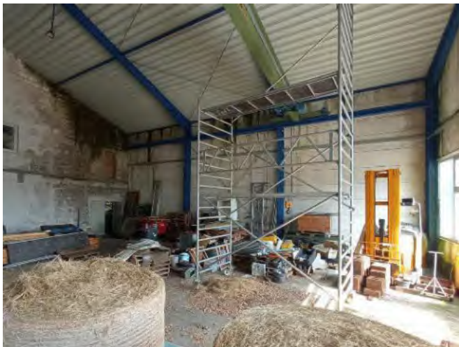
16 + 17 – nördliche Wand mit Kranbahn
