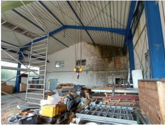
14 + 15 – Stirnwand zum Bürotrakt
