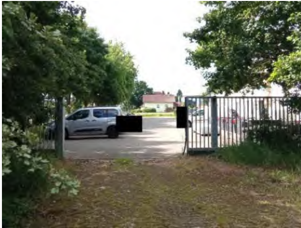
02 – Zufahrt über Nachbargrundstück
