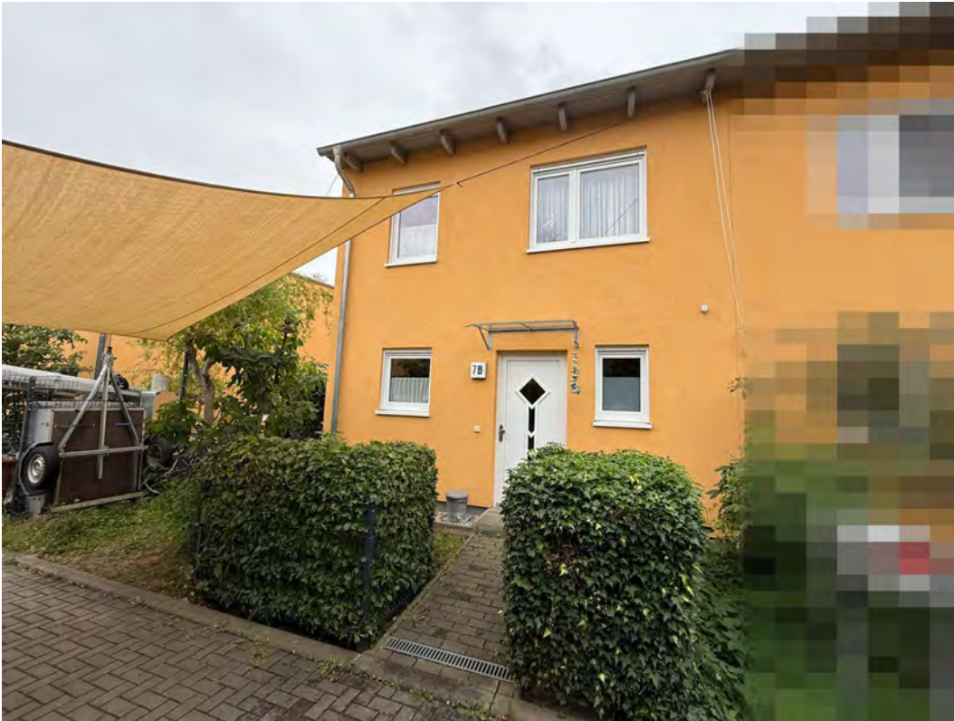
Blick aus östlicher Richtung auf die Hauseingangsseite
