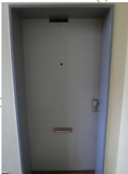
Wohnungseingangstür der gegenständlichen Einheit Nr. 3 im 1. Obergeschoss links
