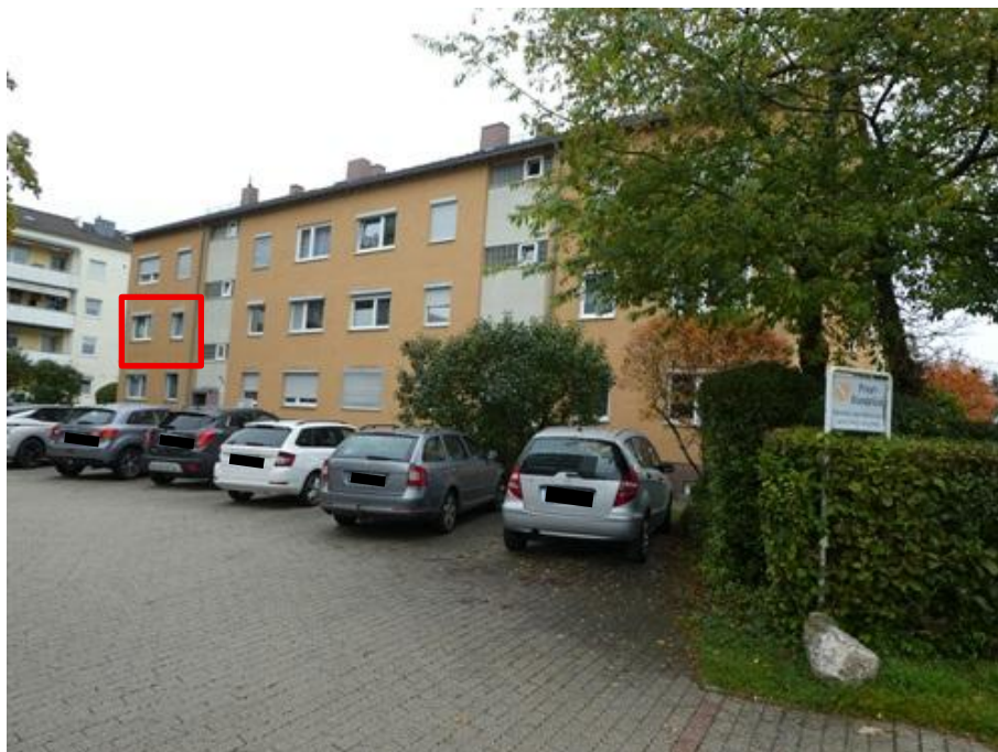
Nordwestansicht Wohngebäude Martin-Luther-Weg 1 und 3 mit gegenständlicher Einheit
