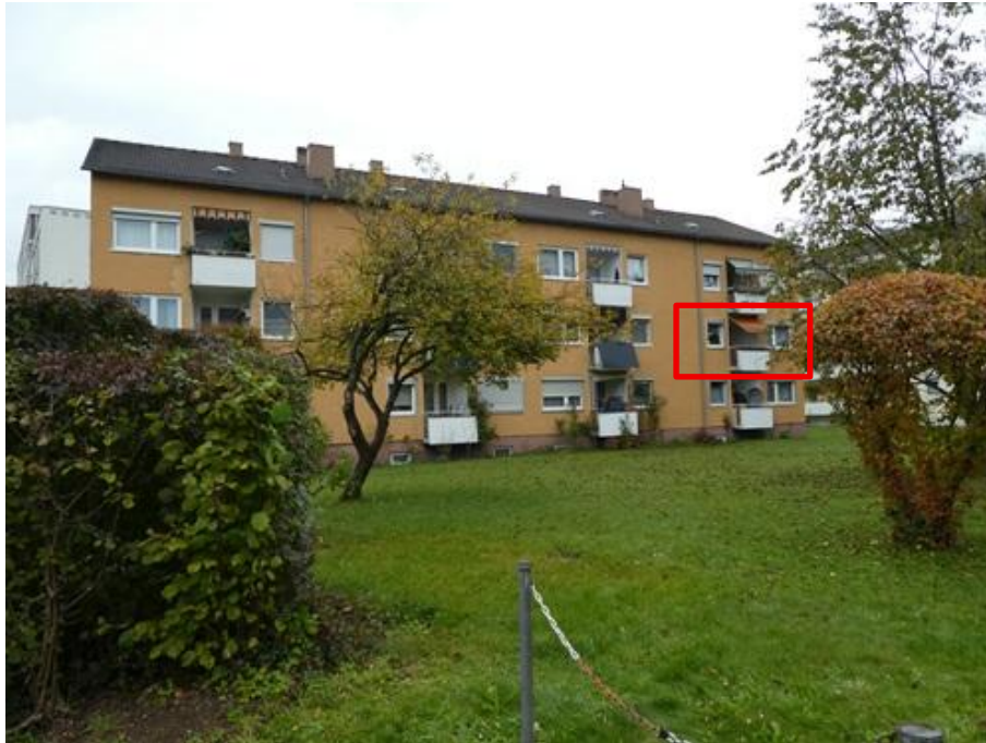
Südostansicht Wohngebäude Martin-Luther-Weg 1 und 3 (Hinweis: Im Folgenden wird die Lage der gegenständlichen Eigentumswohnung jeweils rot markiert.)
