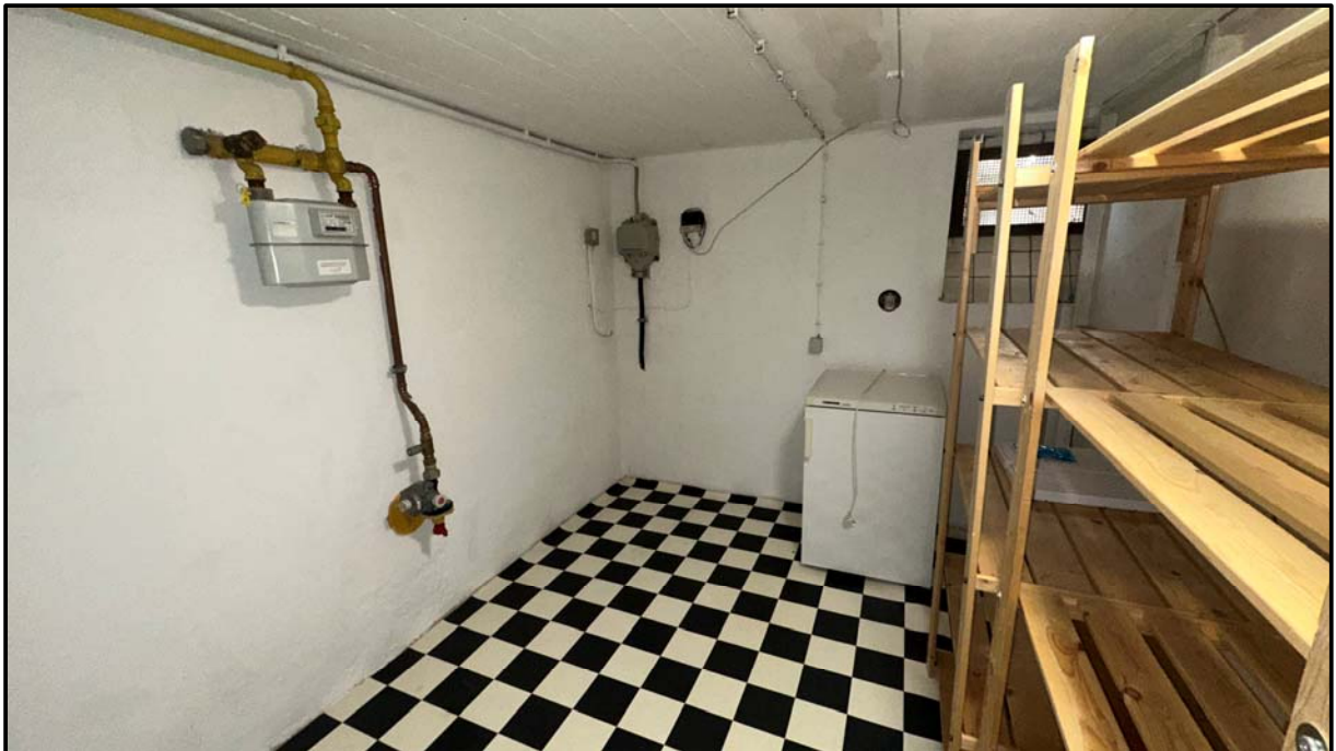
Wohneinheit Nr. 2: Kellerraum
