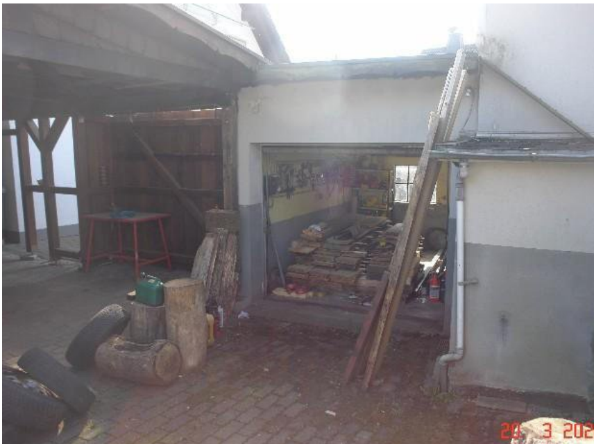
Bild 8: Ansicht der Garage
