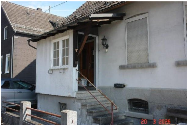
Bild 4: Ansicht des Hauseingangsbereichs
