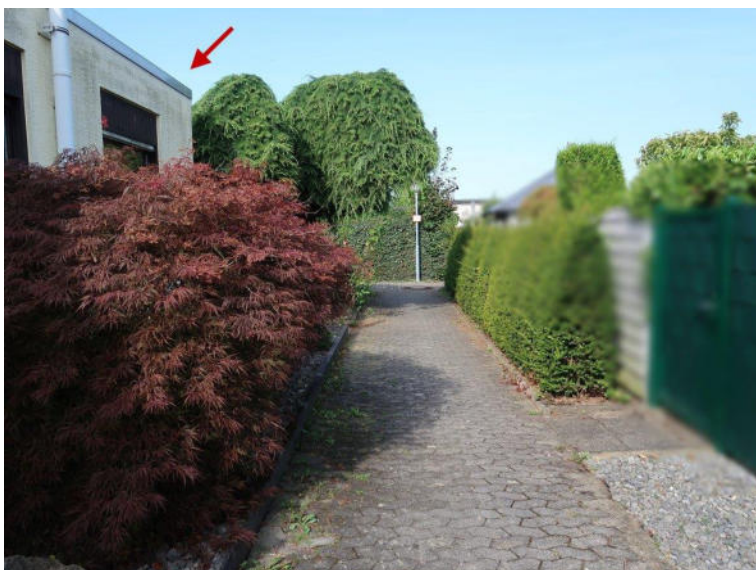
Bild 3 Außenansicht Wohnhaus mit Zuwegung
