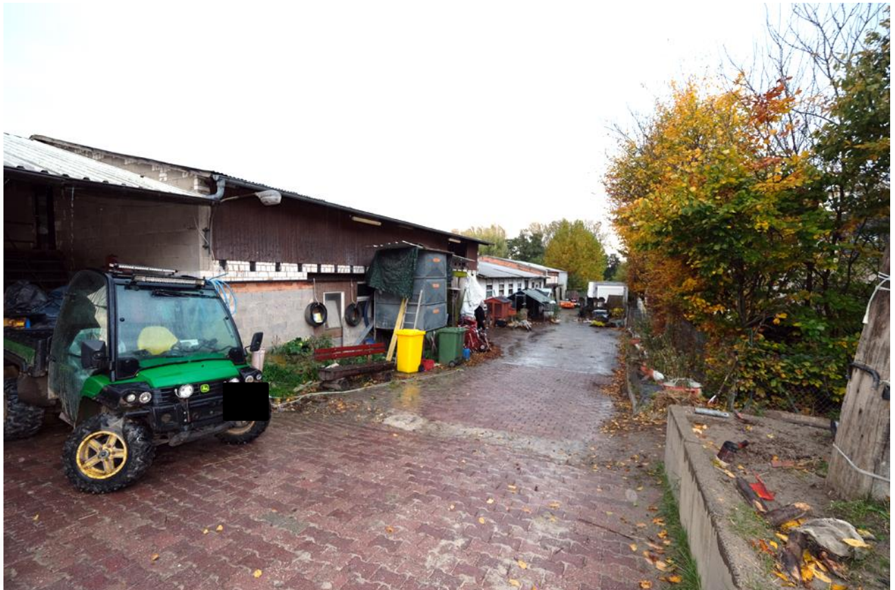
Blick von Ost nach West. Das Flurstück ist mit landwirtschaftlich genutzten Hallen-Gebäuden bebaut.
