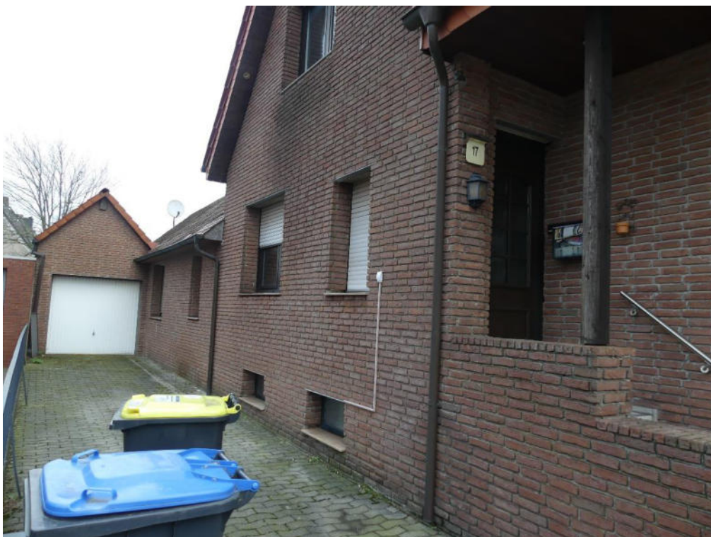
Zufahrt zur Garage
