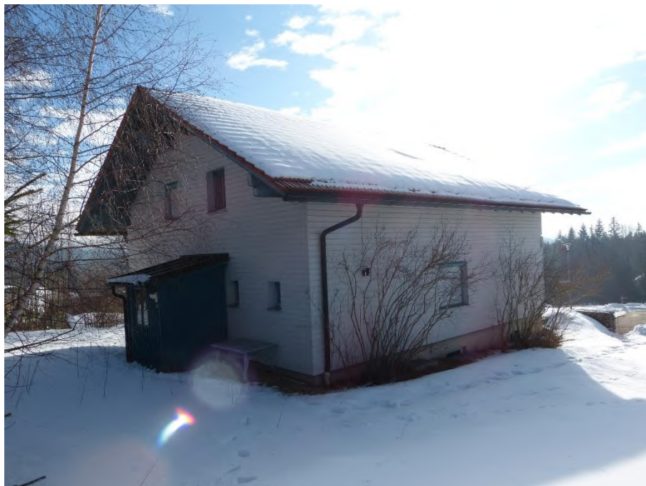
Gebäude 1: Zweifamilienhaus, Ansicht von Nordwesten
