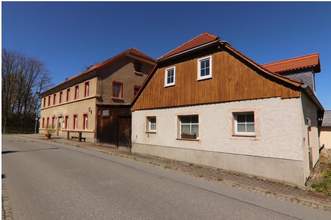
Blick von der Amtsgerichtsstraße in nordwestliche Richtung auf das Flurstück 1755. Der rechte Gebäudeteil wurde als Schlacht- und Zerlegebereich einer Fleischerei genutzt. Ganz links ist das historische Geschäftshaus erkennbar, das als Gasthof und Fleischereiverkauf genutzt wurde.
