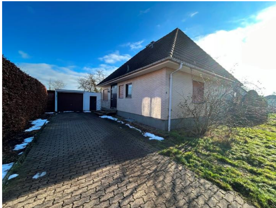
Nordwestansicht (Straßenansicht) des Einfamilienhauses und der Garage
