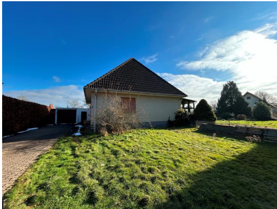
Westansicht (Straßenansicht) des Einfamilienhauses mit Garage
