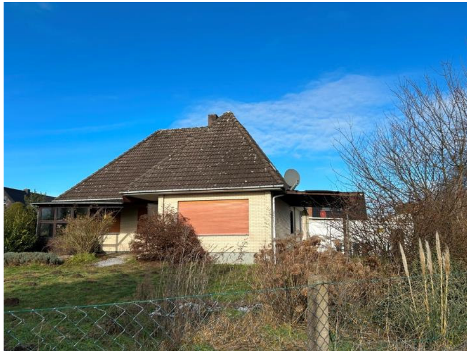
Südostansicht (Rückansicht) des Einfamilienhauses
