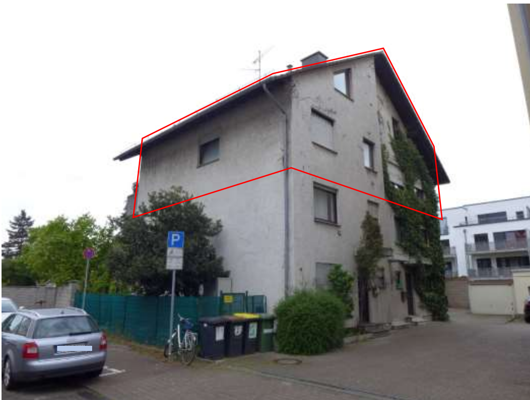
2 Südostansicht, Lage des Bewertungsobjekts markiert
