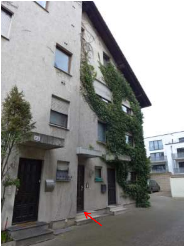
7 a Ostseite, Aufzug Whg. Nr. 3
