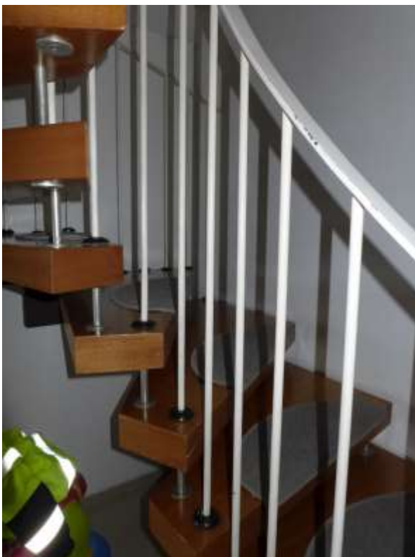
16 a interne Treppe zum DG
